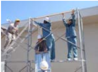
足場組み立て
