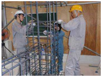
柱・梁の鉄筋組み立て
