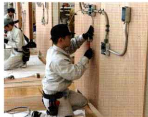
電気工事部門
