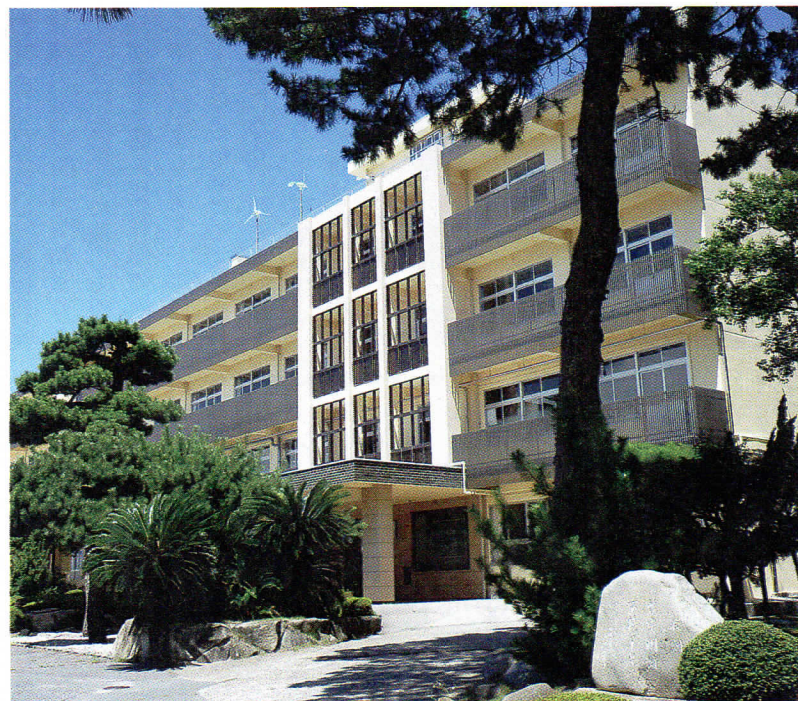
外壁リフレッシュ工事完了後の本館
