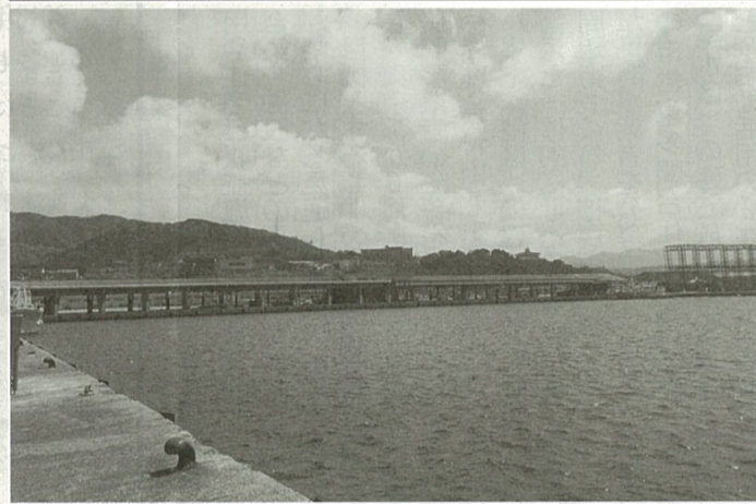
高度衛生管理型荷捌所を整備する浜田漁港の4号(左側)・7号岸壁＝浜田市原井町
