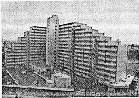
写真-1 現場全景
