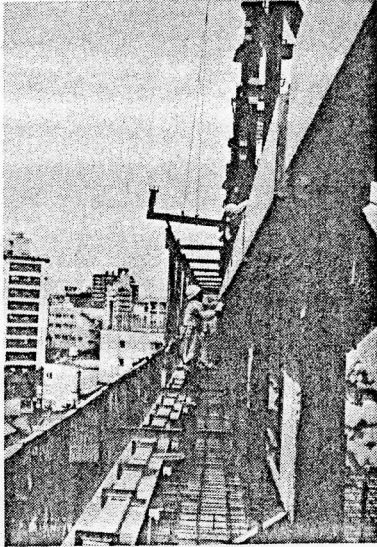
写真-3 養生足場の盛替え
