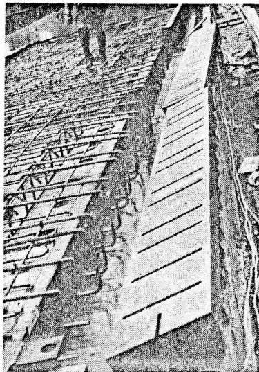
写真-2 戸境壁、梁のフラットバーとスターラップ
