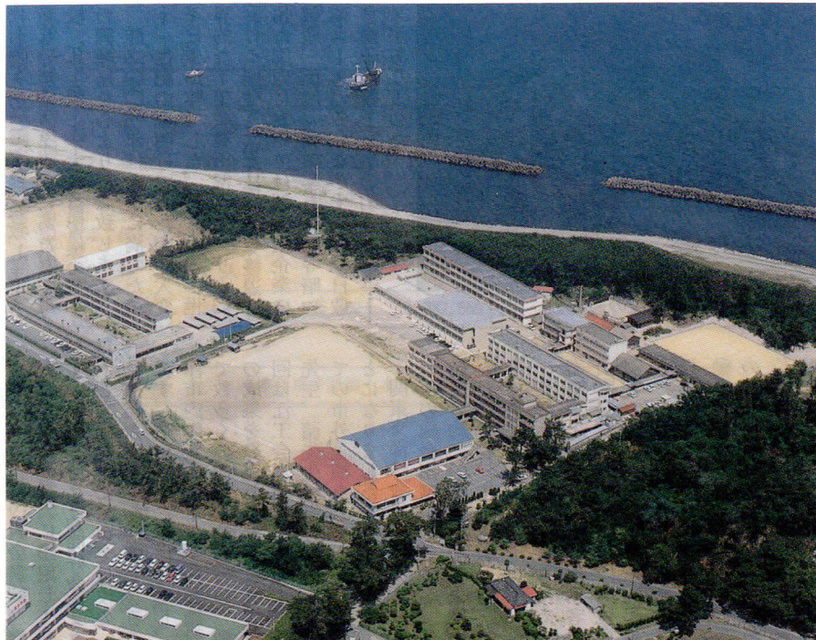
空から見た江工全景
